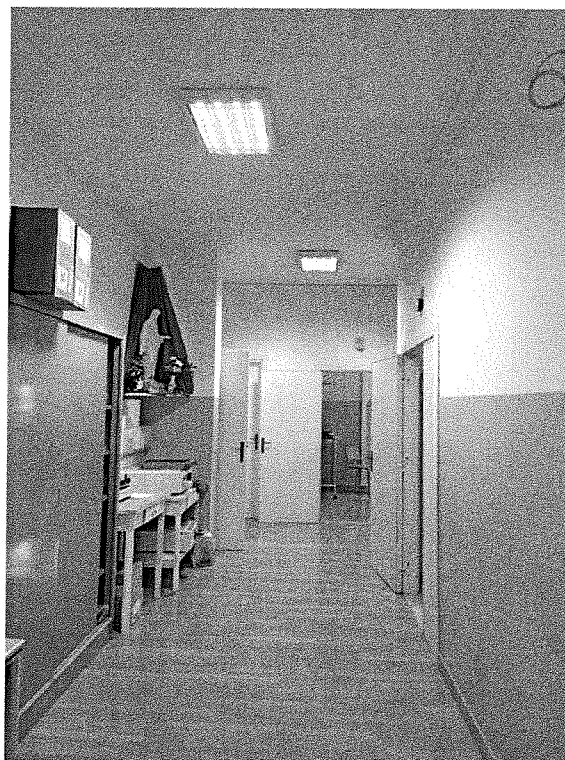
Foto 4: stato attuale della zona in cui verranno realizzati gli uffici amministrativi
